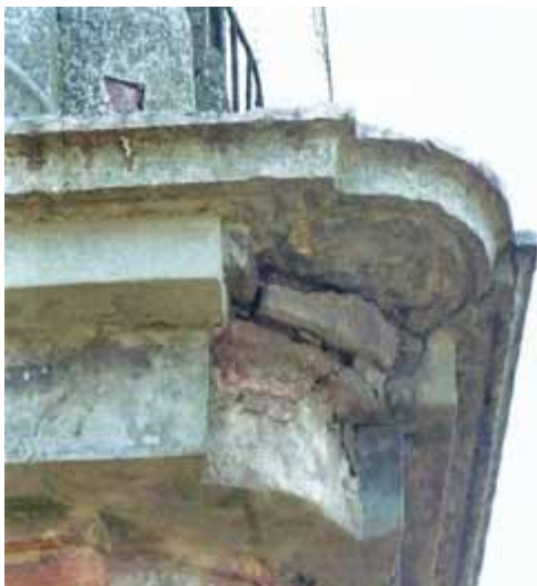
Cornici della cella campanaria
