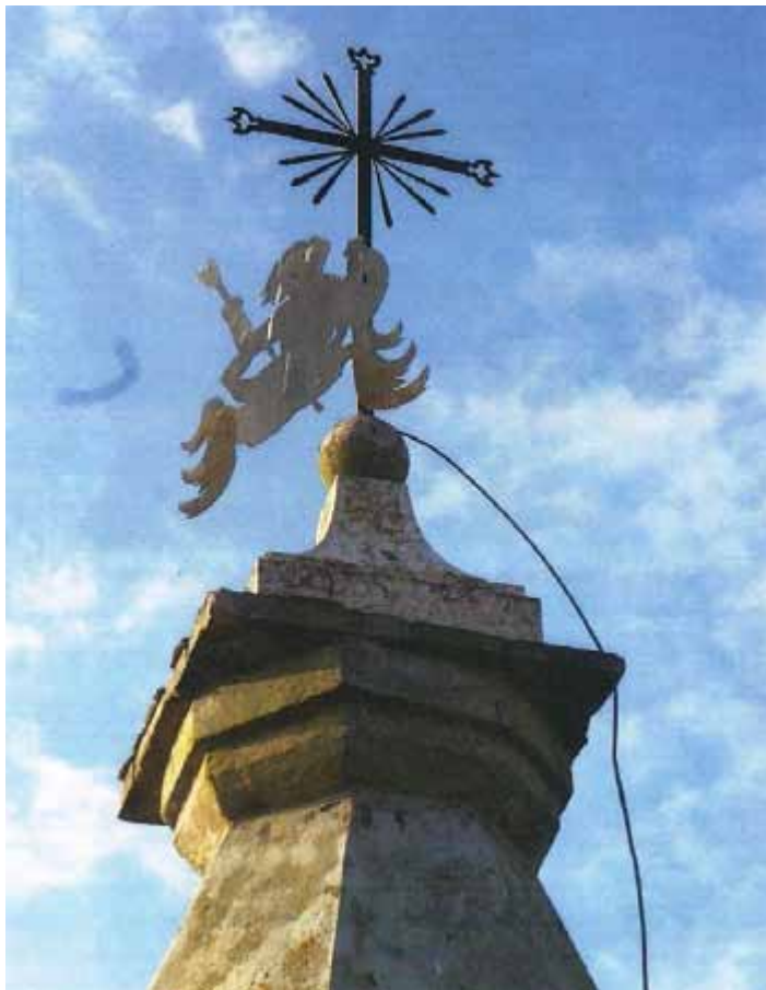
Campanile - Porzione sommitale
